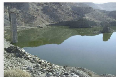
● Kef Eddour sludge bassin
