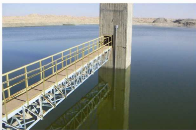
● Mdhilla sludge bassin
