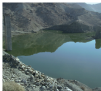
KEF EDDOUR SLUDGE BASSIN
